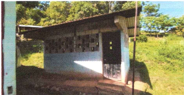
Foto1: MEJORAMIENTO DE AULA
